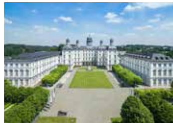
Althoff Grandhotel Schloss Bensberg, Bergisch-Cladbach/Köln
